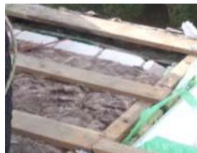
уплотнитель для возможности циркуляции воздуха в подкрышном пространстве и не допуске заметания во внутрь снега;
