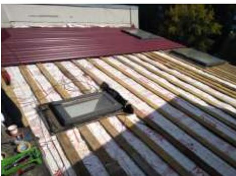
дополнительное утепление углов, примыканий, кирпичных стен утеплителем
